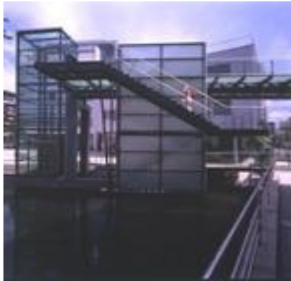
Fußgängerbrücke über die B 312 am Knoten Lindach in Reutlingen
